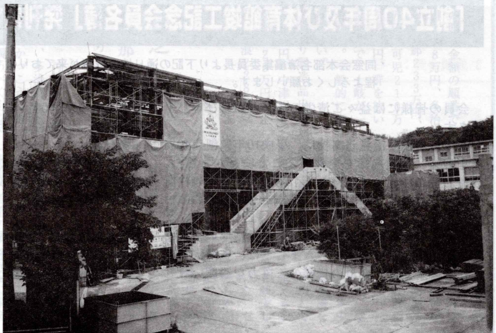
建築中の新体育館
